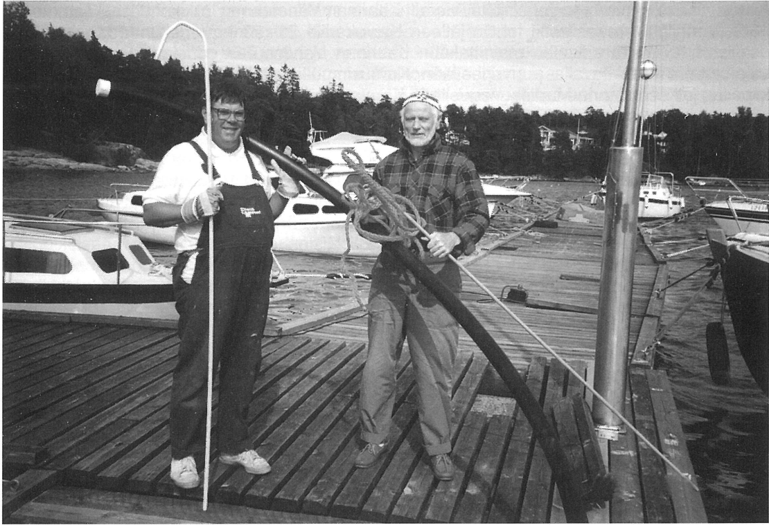
Sähköjohtojen suojausputkitus: Antti Laine ja komm. Matti Lipasti.
