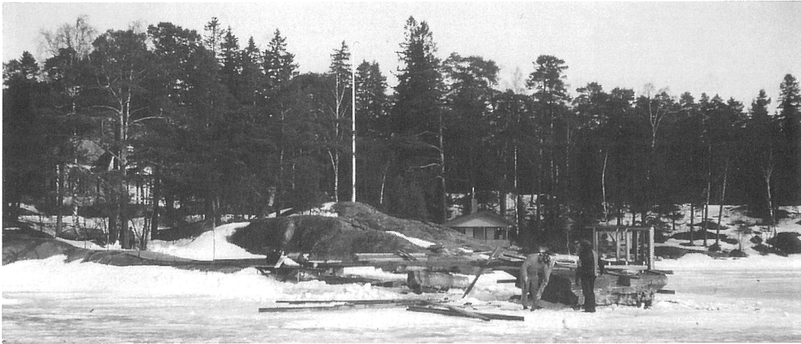
Ensimmäinen talkoopäivä 19.03.1977. Betoniarkun verhoilu.
